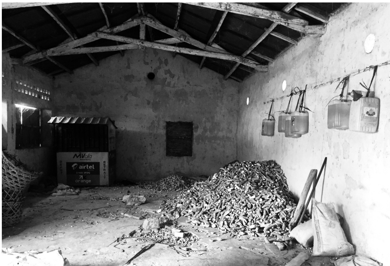
Réserve alimentaire et état des stocks de la maison centrale de Fianarantsoa. Le manioc sec tout juste livré du camp pénal voisin est stocké au sol. Les bidons d'huile sont accrochés au mur pour ne pas être mangé par les rats qui pullulent - février 2023 - © Samuel Gautier
